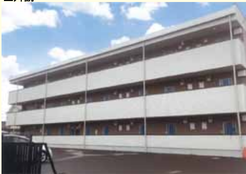
鉄筋ALC3階建
