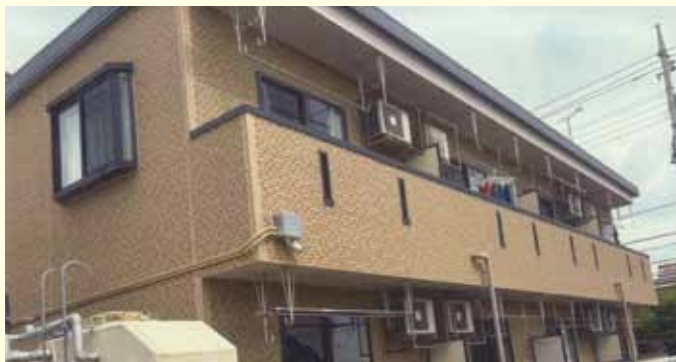
鉄骨ALC2階建
