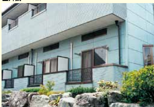
鉄骨ALC2階建
