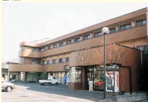
鉄骨ALC3階建
