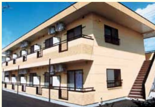
鉄骨ALC2階建
