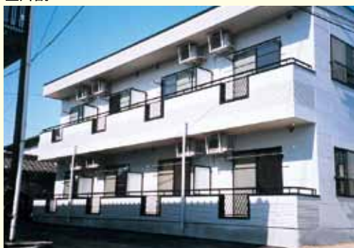
鉄骨ALC2階建
