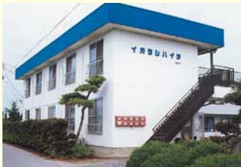
鉄骨ALC2階建
