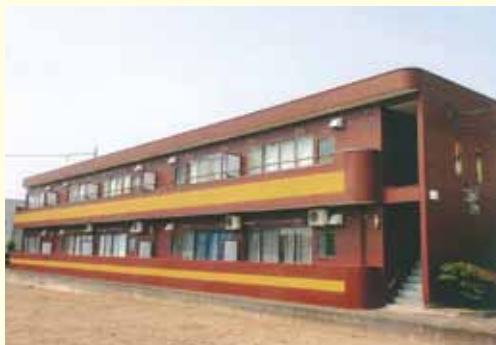
鉄骨ALC2階建
