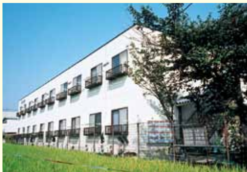
鉄骨ALC2階建
