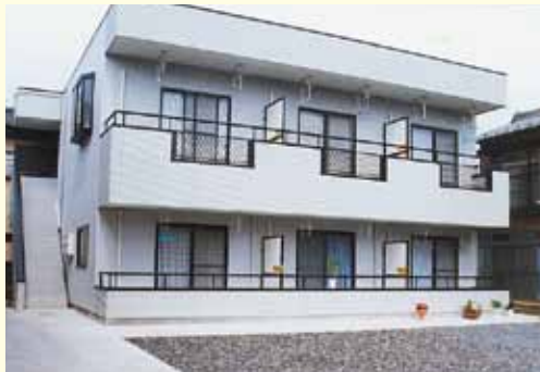
鉄骨ALC2階建
