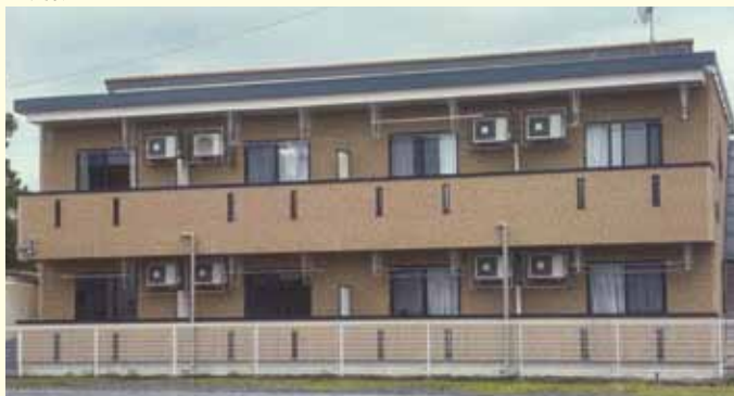
鉄骨ALC2階建
