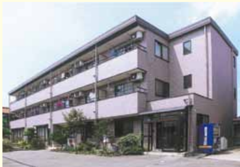
鉄骨ALC3階建
