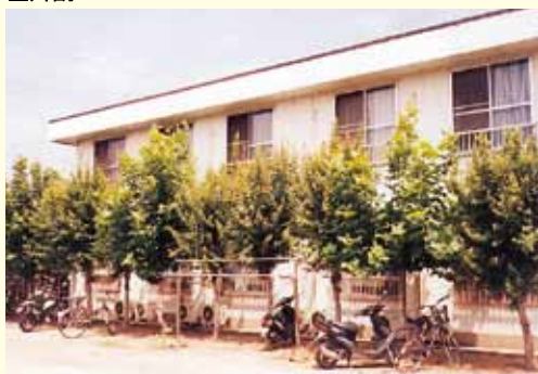
鉄骨ALC2階建
