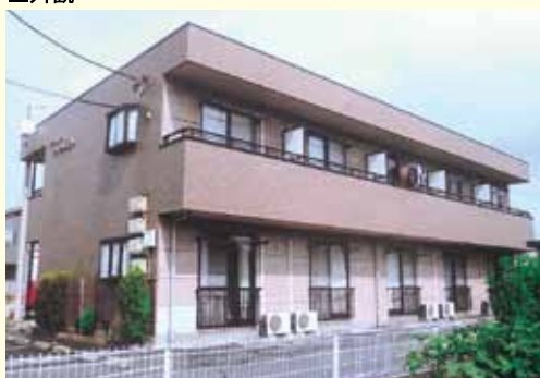
鉄骨ALC2階建
