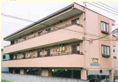
鉄骨ALC3階建
