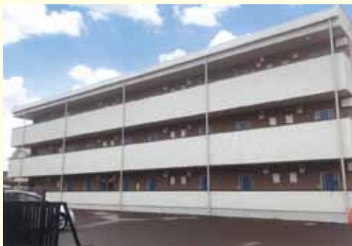
鉄筋ALC3階建
