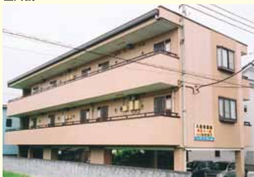
鉄骨ALC3階建
