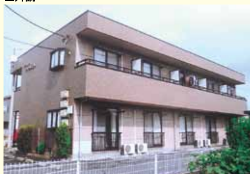
鉄骨ALC2階建
