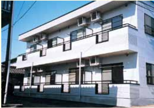
鉄骨ALC2階建
