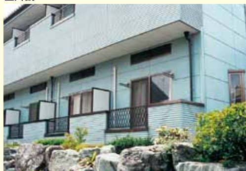
鉄骨ALC2階建
