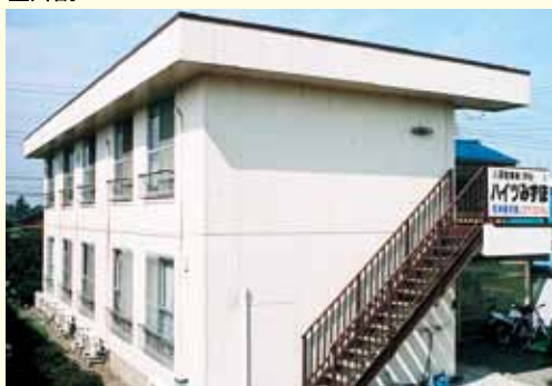
鉄骨ALC2階建
