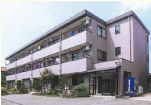
鉄骨ALC3階建
