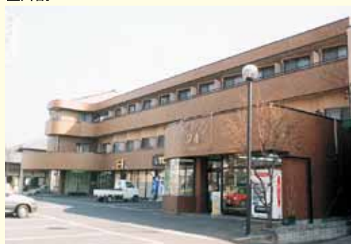
鉄骨ALC3階建
