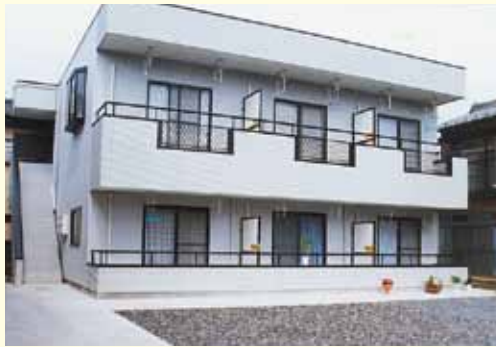
鉄骨ALC2階建
