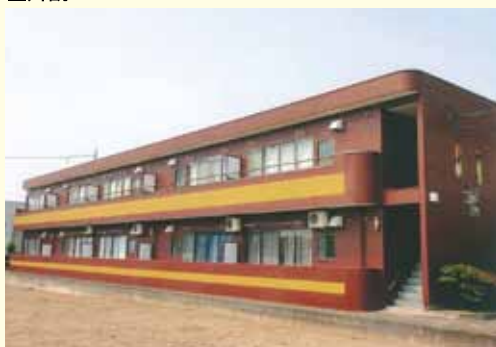
鉄骨ALC2階建
