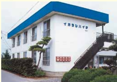
鉄骨ALC2階建
