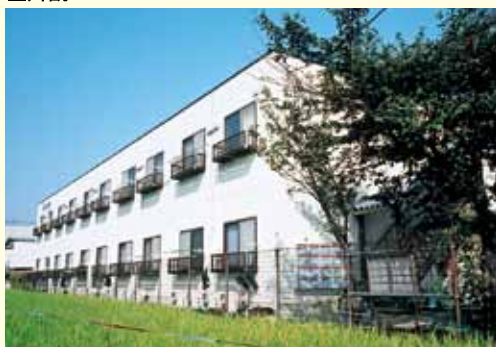
鉄骨ALC2階建
