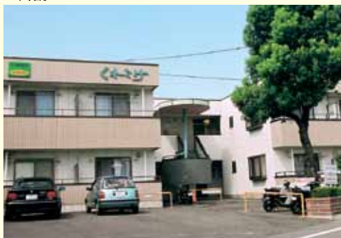
鉄骨ALC2階建
