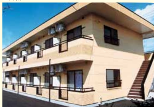
鉄骨ALC2階建
