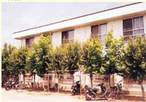
鉄骨ALC2階建
