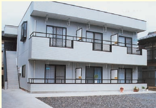
鉄骨ALC2階建
