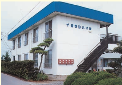
鉄骨ALC2階建
