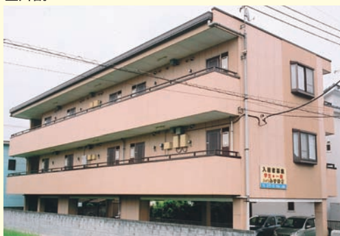
鉄骨ALC3階建
