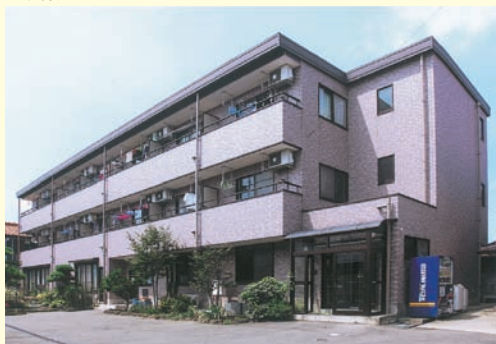
鉄骨ALC3階建
