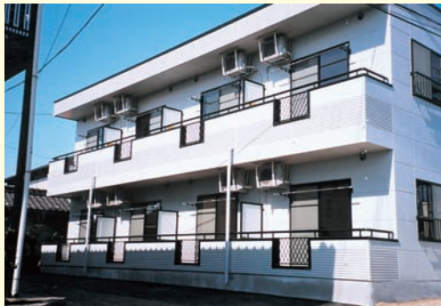
鉄骨ALC2階建
