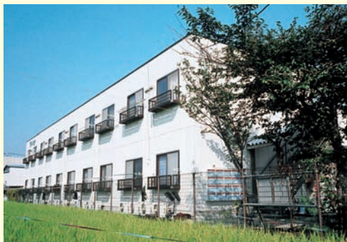
鉄骨ALC2階建
