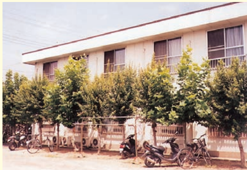
鉄骨ALC2階建
