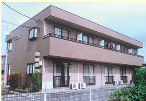
鉄骨ALC2階建
