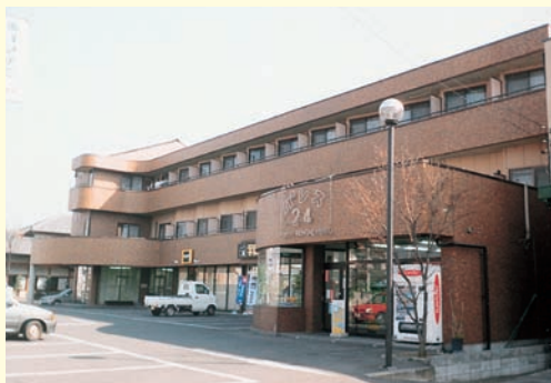
鉄骨ALC3階建
