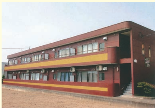
鉄骨ALC2階建
