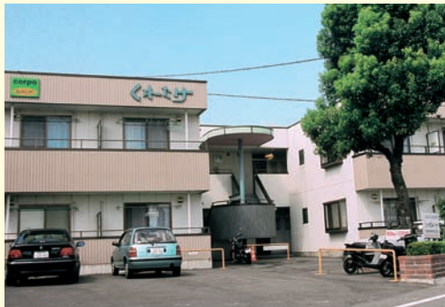
鉄骨ALC2階建
