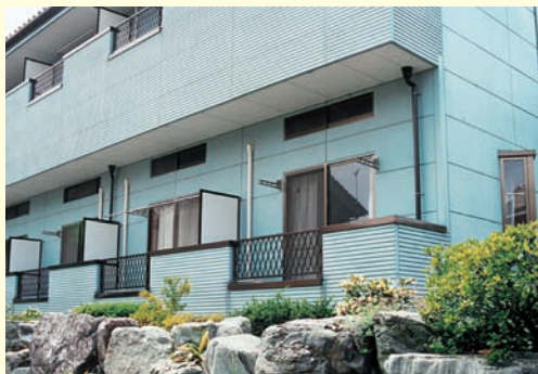
鉄骨ALC2階建
