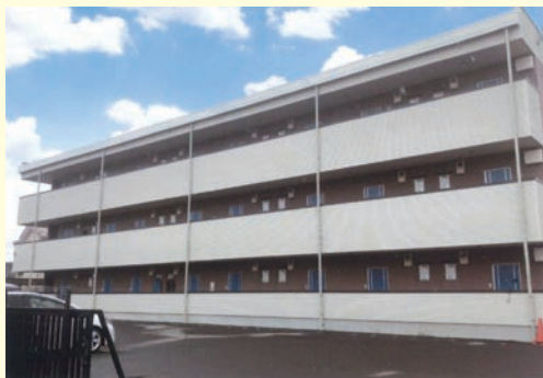
鉄筋ALC3階建
