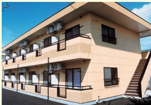
鉄骨ALC2階建
