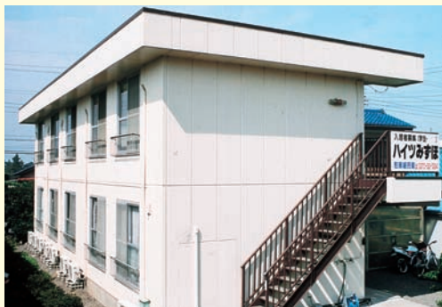
鉄骨ALC2階建
